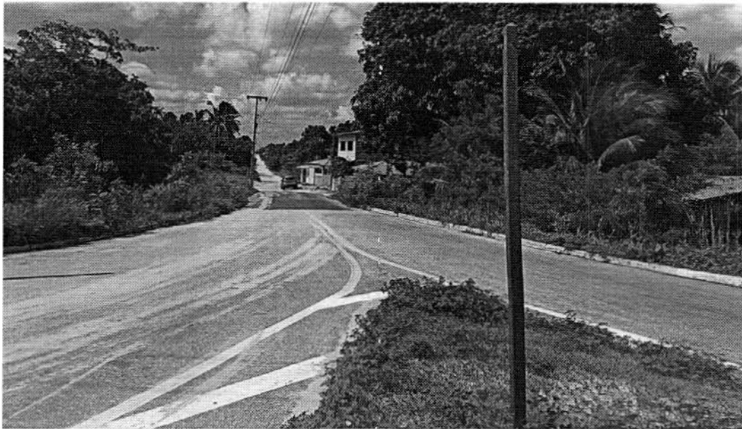
Os 40m iniciais do trecho é composto por camada asfáltica.
