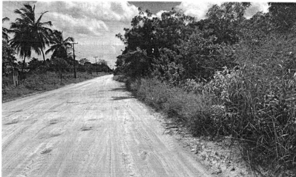
Pavimento primário ao longo de todo o trecho.
