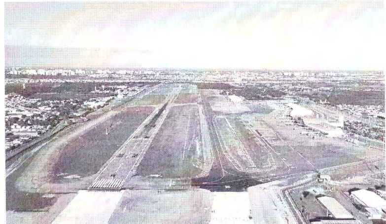
A pista foi expandida em 210 metros, com comprimento total de 2.755 metros. Imagem aérea da obra concluída
